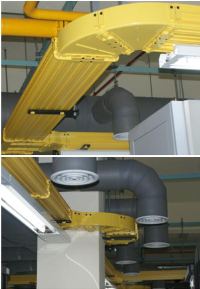
➤ **OptiWay** est conçu pour fournir un système de gestion sécurisé, facile à utiliser et économique pour les câbles optiques fragiles. OptiWay permet de guider les câbles de fibre optique entre les équipements, tout en apportant une protection physique et une gestion des rayons de courbure essentielle à la performance des câbles optiques.
